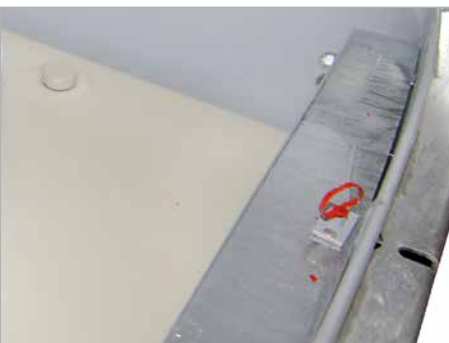
Peilstab für Leckagekontrolle
